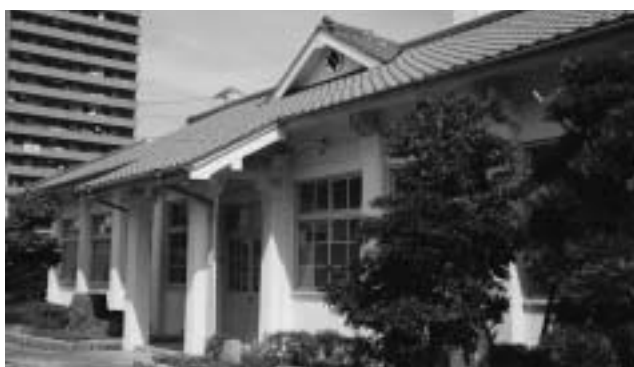
近代和風建築の例(公共建築・喜多町地内)
